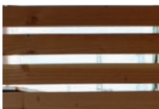
Detailní pohled – dřevěná výpň s průhledem
